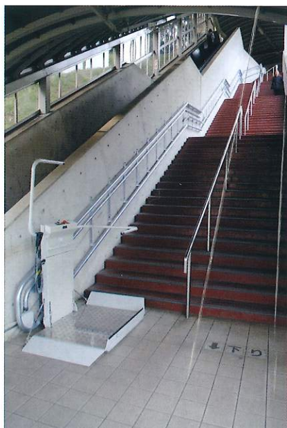
長距離にも対応しています ※写真は昇降行程32mです
